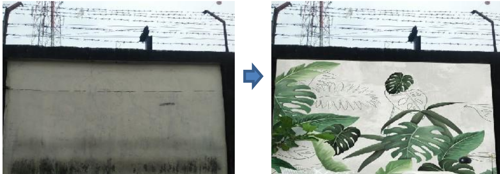
a. Gambar Sebelum dan Sesudah : Grafiti dinding pembatas rel kereta api
