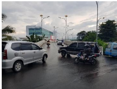
Gambar 1. Kondisi Saat Adanya Pembangunan Flyover Pramuka
